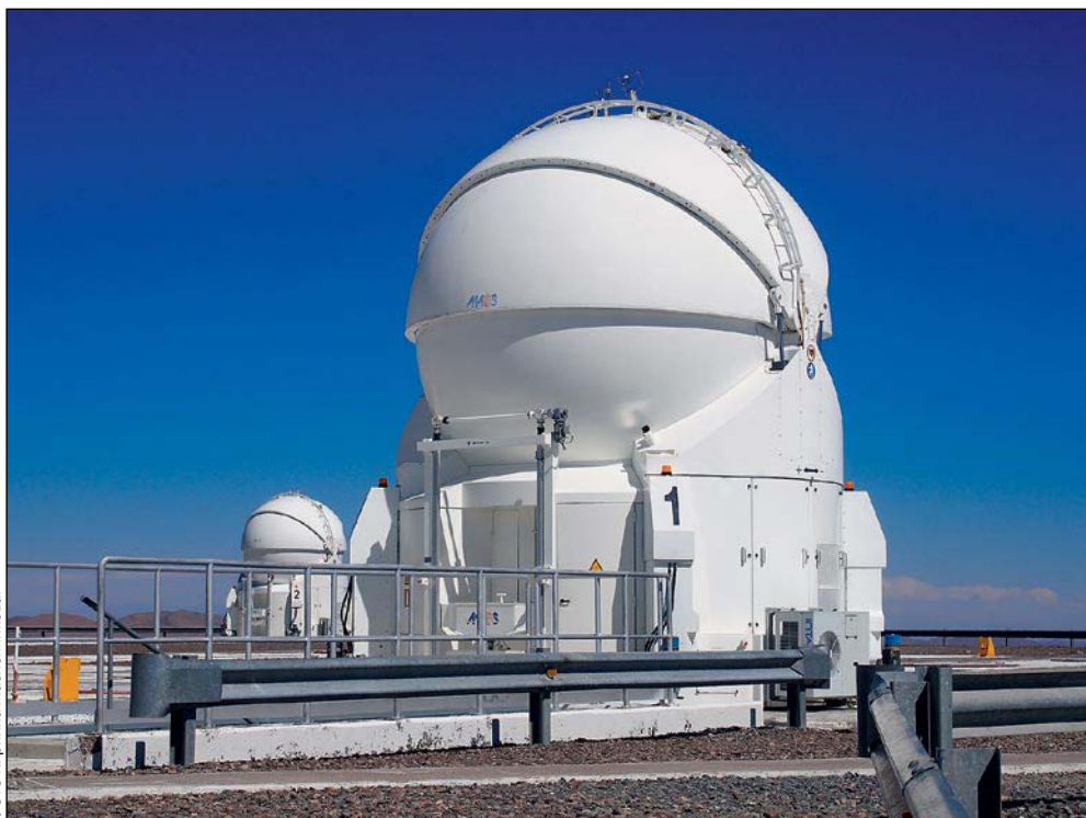
Один из четырёх вспомогательных телескопов VLT с зеркалом диаметром 1,8 м. Он может ездить по рельсовым путям.
